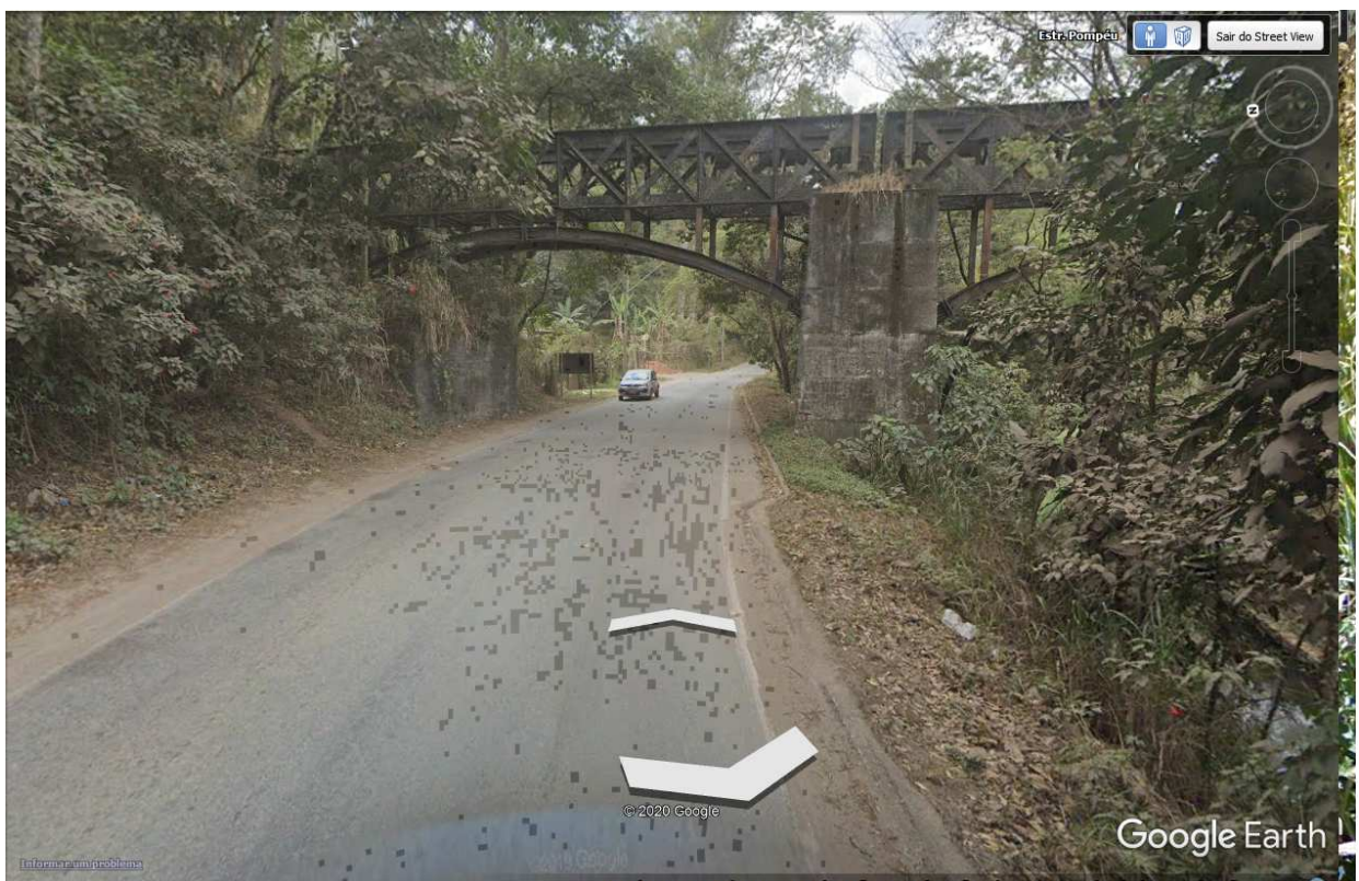
Vão sobre a MGC – 262 – Sabará / Bairro Pompéu / Caeté - detalhe estrutura metálica e apoios
