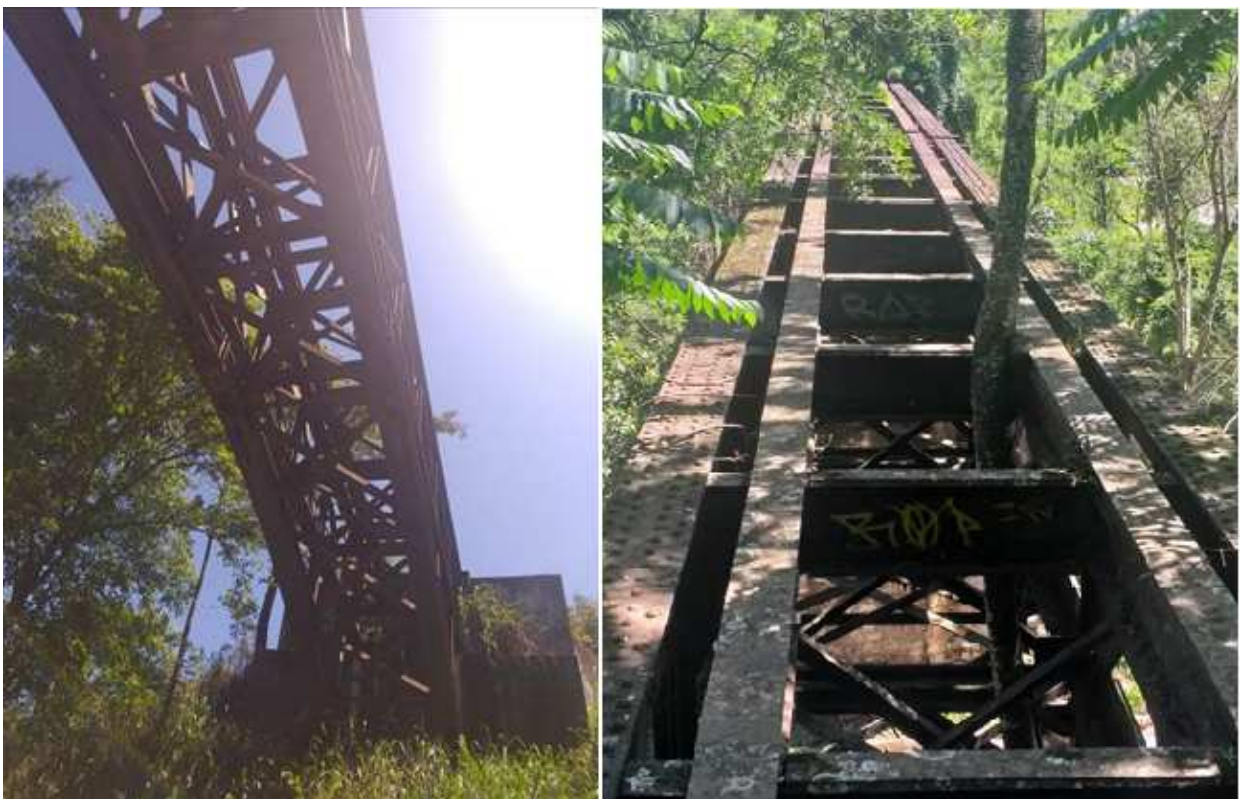
Detalhe estrutura metálica área total estimada 863,00 m 2 – vista inferior e superior
