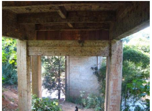
Vista inferior – pilares P2E e P2D.
