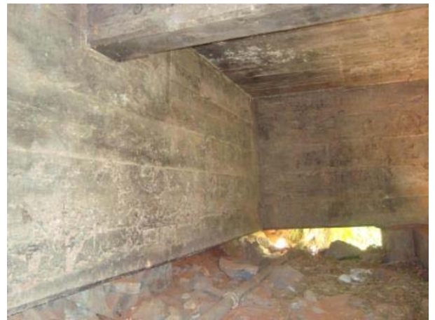
Vista inferior (encontro E1).
