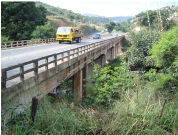
Vista lateral direita sentido Belo Horizonte – Sabará – (encontro E1).
