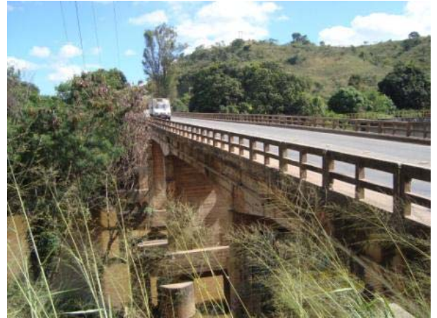
Vista lateral direita sentido Sabará – Belo Horizonte – (encontro E2).
