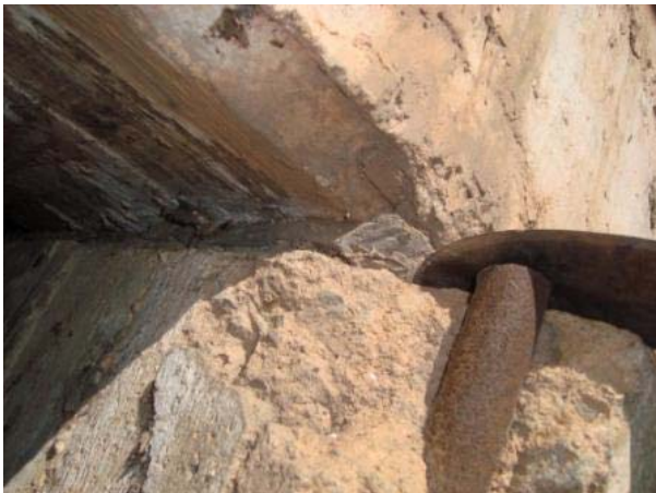
Vista inferior lateral esquerda - longarina apoiada no pilar P1E.
