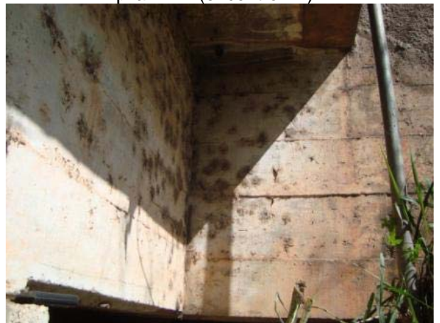
Vista inferior lateral esquerda (encontro E1).
