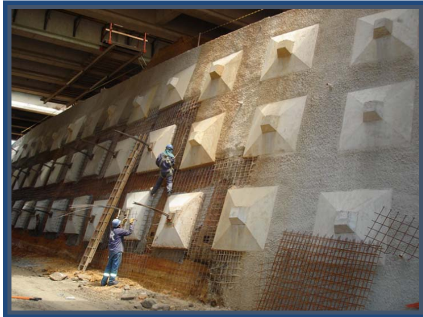
Figura 6- Aparência da obra sendo finalizada Créditos: Construtora A. Gutierrez
