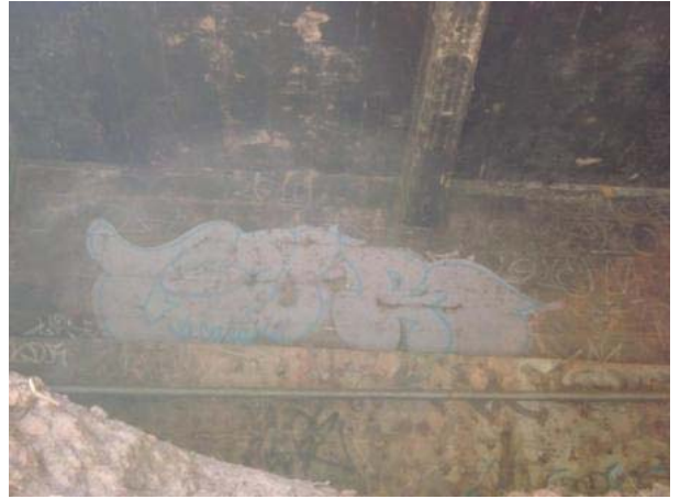
Vista inferior (encontro E2).
