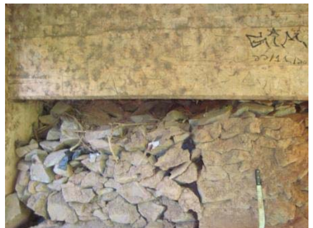
Vista inferior da viga de contraventamento de pilar (encontro E1).
