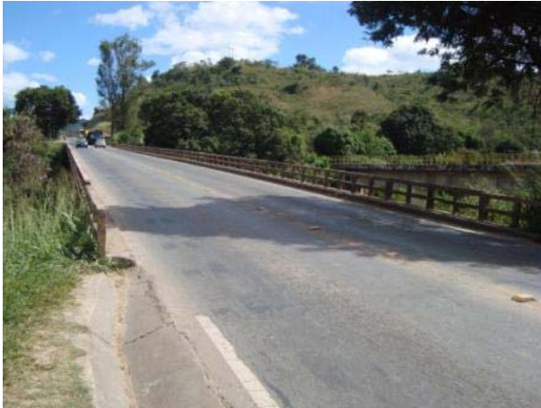
Vista superior sentido Sabará – Belo Horizonte – (encontro E2).
