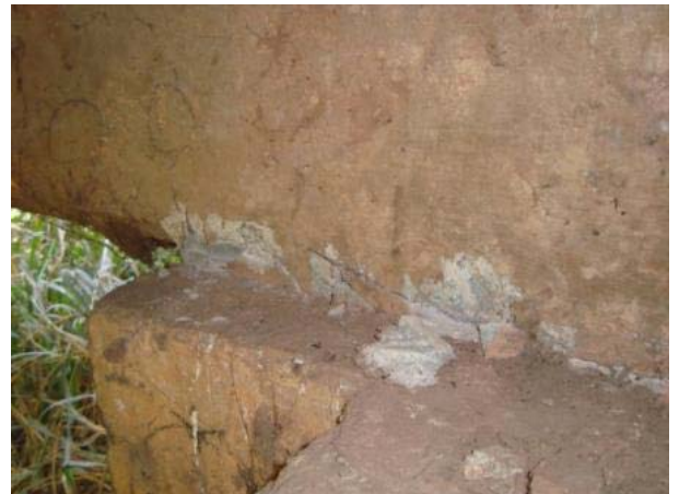
Vista da longarina lateral direita apoiada no pilar P1D e viga de contraventamento (encontro E1).
