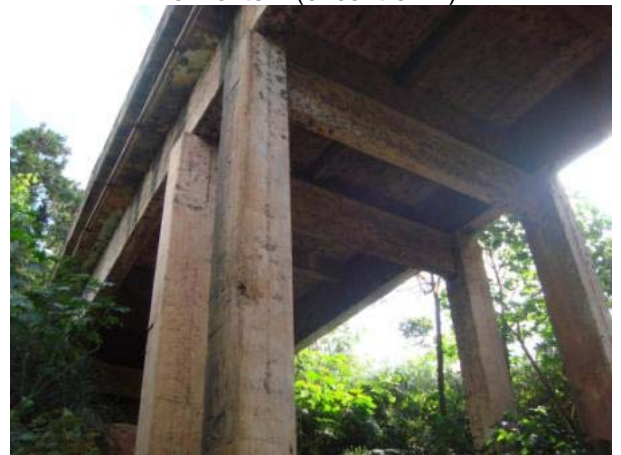
Vista inferior lateral direita - pilares P2D e P3D.
