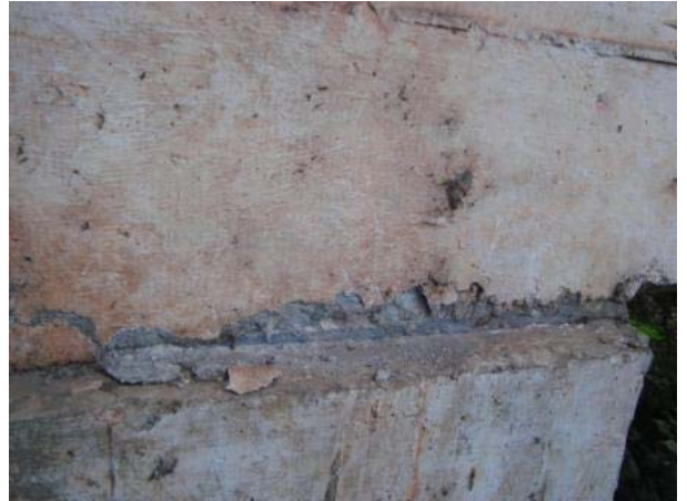
Vista da longarina lateral esquerda apoiada no pilar P1E (encontro E1).
