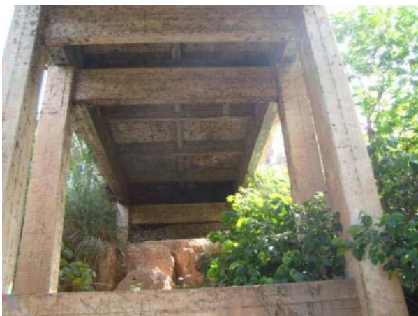
Vista inferior (encontro E1).
