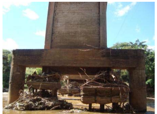
Vista inferior – tubulão dos pilares P5E e P5D.
