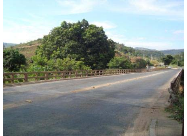
Vista superior sentido Belo Horizonte – Sabará – (encontro E1).
