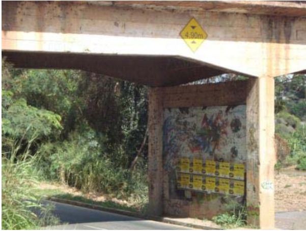
Vista lateral esquerda - pilares P8D e P8E.
