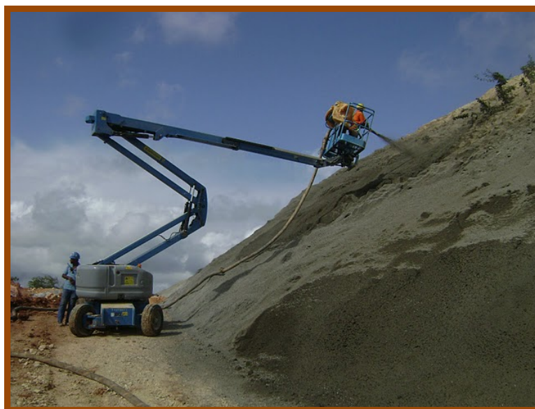
Fig. 5 – Utilização de Guindastes com Gaiola
