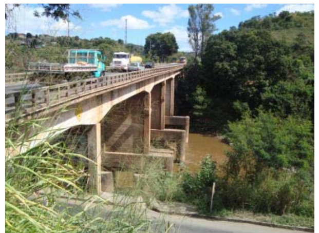
Vista lateral esquerda sentido Sabará – Belo Horizonte – (encontro E2).
