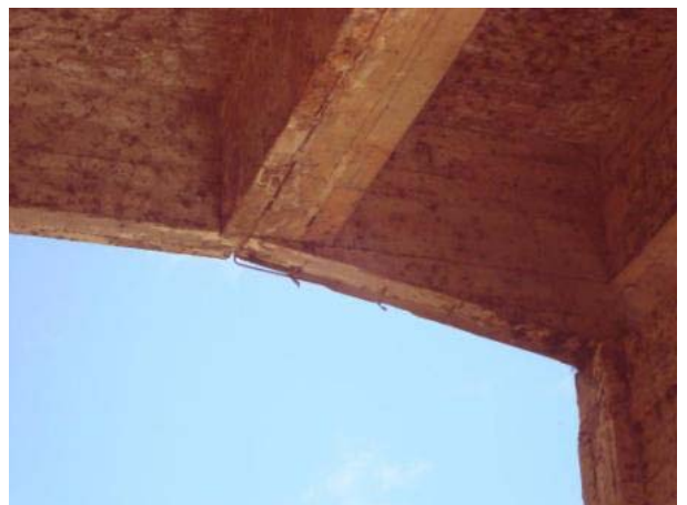
Vista inferior lateral direita – dente Gerber (verificar condições).
