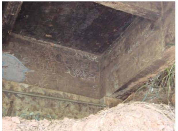
Vista inferior (encontro E2) – longarina lateral direita apoiada no pilar P9D.
