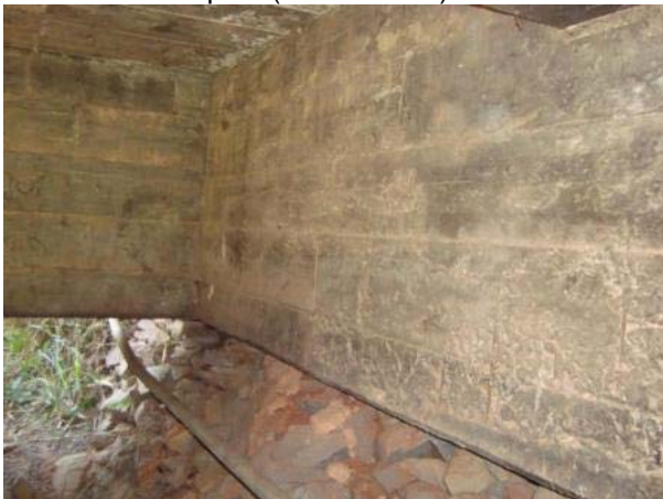
Vista inferior (encontro E1).
