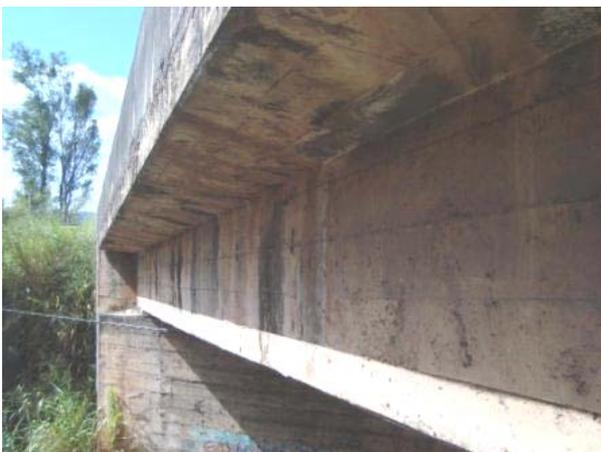
Vista lateral esquerda – laje em balanço e longarina com escoamento de água devido ausência de pingadeira.
