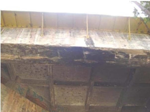
Vista inferior lateral direita - longarina lateral direita com deslocamento de concreto.
