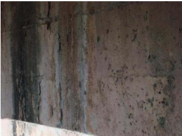
Vista lateral esquerda – longarina com deslocamento de concreto.
