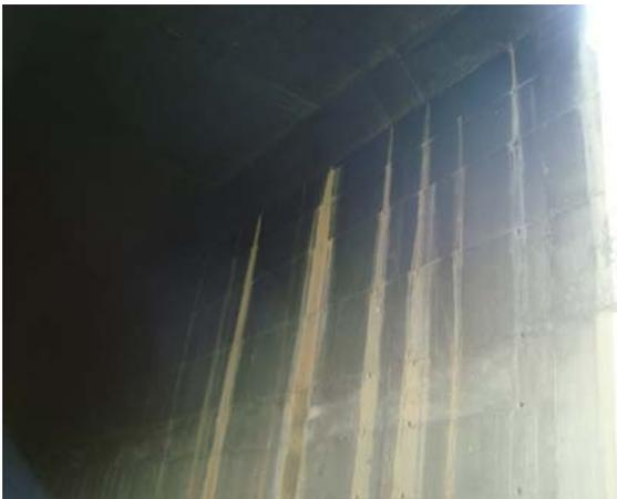
Vista inferior lateral direita - parede frontal do encontro E2 com escoamento de água.
