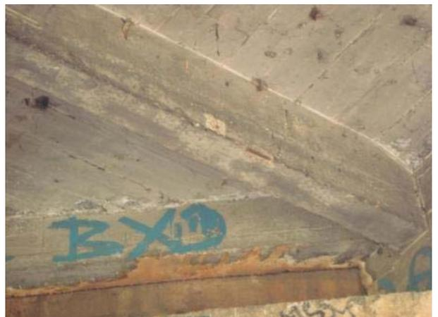
Vista da transversina com concreto quebrado, armadura exposta e oxidada.
