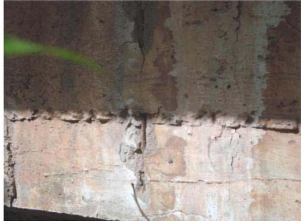
Vista lateral esquerda – longarina com concreto quebrado e com armadura exposta e oxidada.
