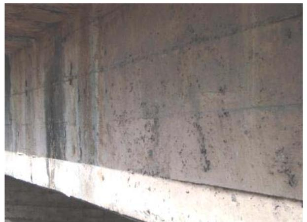
Vista lateral esquerda – longarina com escoamento de água devido ausência de pingadeira.
