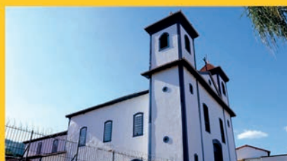
Igreja de Nossa Senhora das Mercês ☑ Rua da Intendência - Centro
