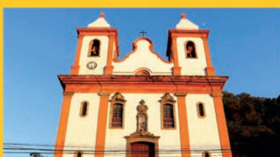
Igreja de São Francisco de Assis ☑ Rua São Francisco - Centro
