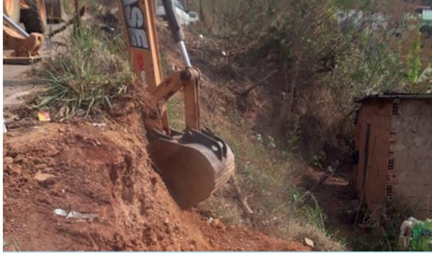
Foi iniciada a construção do muro de contenção na rua Mercúrio, no bairro Bom Retiro. A estrutura irá conter a terra, impedindo deslizamentos e invasões que podem resultar em acidentes.
