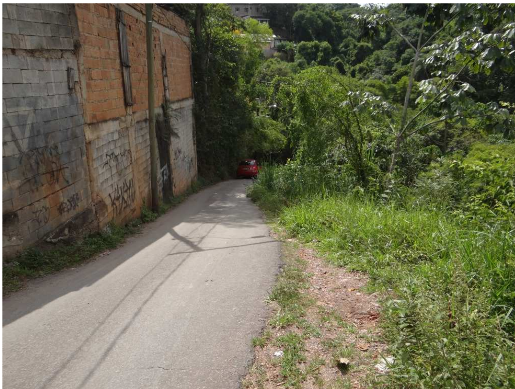
Figura 03 – Via estreita com superfície irregular.
