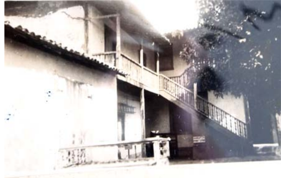
Figura 2: Pátio à época do tombamento. Em primeiro plano, embaixo, o "palanque" mencionado em ofício por Epaminondas Macedo. Nota-se que o segundo pavimento do bloco lateral era menor do que nos dias de hoje. Sob a varanda lateral não havia, nessa época, os sanitários hoje existentes (Fonte: Arquivo Iphan Central, s/d).
