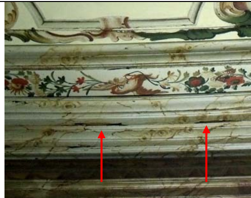
Figura 77: Roda Teto - Perdas causadas por ataque de insetos xilófagos com formação de galerias expostas no lado direito da porta;
