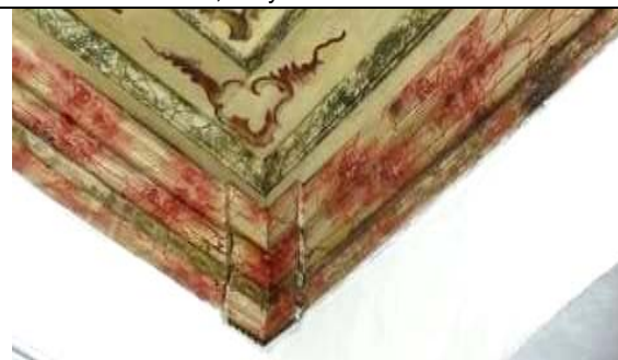
Figura 52: Roda Teto - Em outra área, também se observa deslocamento de blocos com frestas e desnível nas junções das molduras, consolidações anteriores inadequadas mal planificadas com material escuro de aspecto grotesco.
