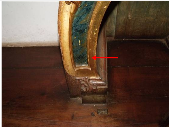
Figura 41: Base da lateral direita, pequenas perdas da policromia e douramento, manchas de materiais de limpeza e furo no piso provavelmente havia alguma peça no original. Autor/Data: Lara, Elayne, 2013.
