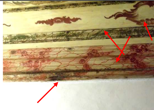
Figura 52: Roda Teto - Em outra área, também se observa deslocamento de blocos com frestas e desnível nas junções das molduras, consolidações anteriores inadequadas mal planificadas com material escuro de aspecto grotesco.
