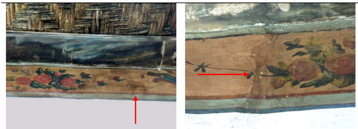
Figura 125: Aba com manchas escuras na policromia.
