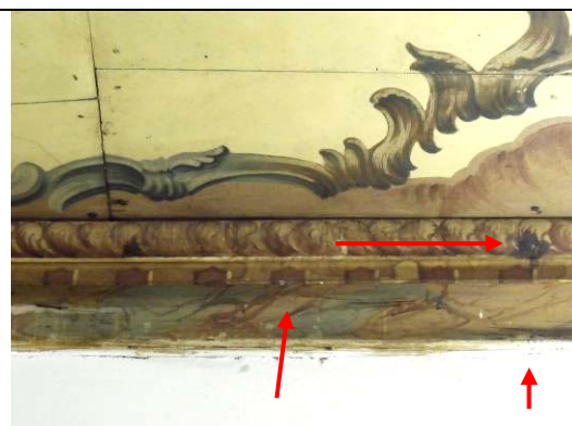
Figura 112: Roda Teto - Manchas de respingos de tinta branca (recente), sobreposição da mesma tinta na moldura de arremate; Mancha com tinta preta;
