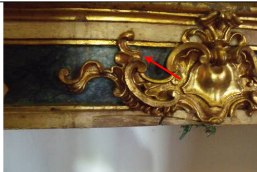
Figura 39: Perda de policromia e douramento no arremate abaixo da mesa do altar. Autor/Data: Lara, Elayne, 2013.
