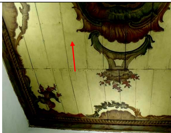
Figura 117: Tábuas do Forro - Manchas de repintura na área de fundo (bege) com alteração da cor.
