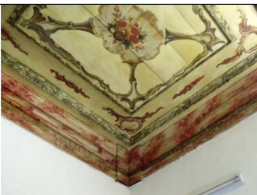
Figura 62: Canto com demonstração de roda teto, tábuas que dividem os caixotões e caixotão 4
