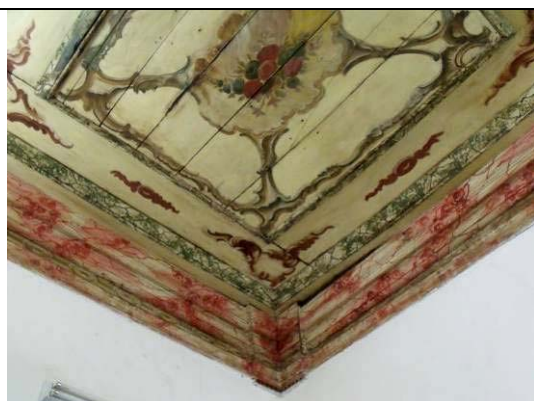
Figura 61: Canto com demonstração de roda teto, tábuas que dividem os caixotões e caixotão 3
