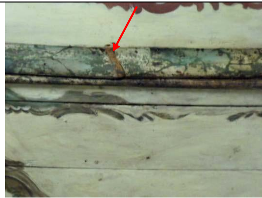
Figura 64: Caixotão 3 - Ranhuras provocadas por algum objeto que removeu parte do suporte e a camada pictórica.
