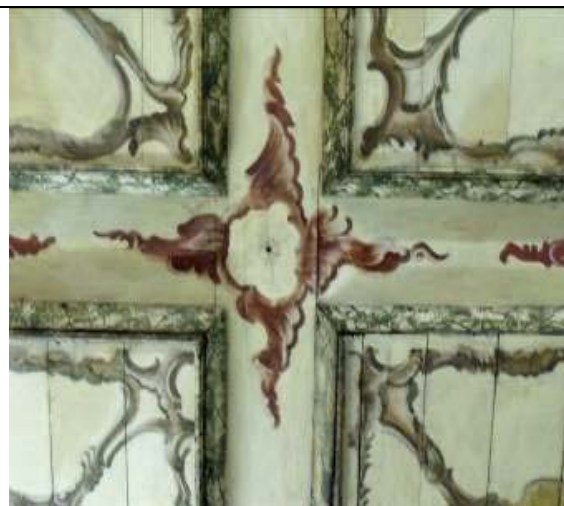
Figura 66: Centro dos caixotões - Deslocamento de tábuas, causando frestas, perda de filete, manchas de oxidação, manchas de umidade.
