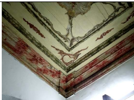
Figura 59: Canto com demonstração de roda teto, tábuas que dividem os caixotões e caixotão 1
