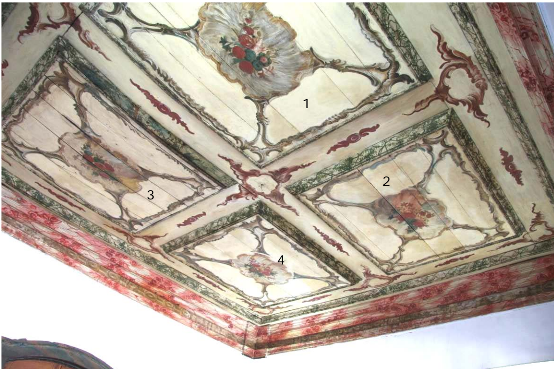
Figura 50: Forro do Cômodo 3 – Vista geral. Autor: Assis, Adriana, janeiro de 2013.
